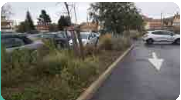
→ Noue d'infiltration sur le parking
